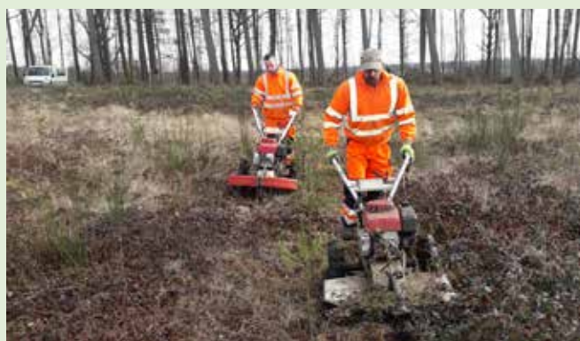
Travaux dans les bois
